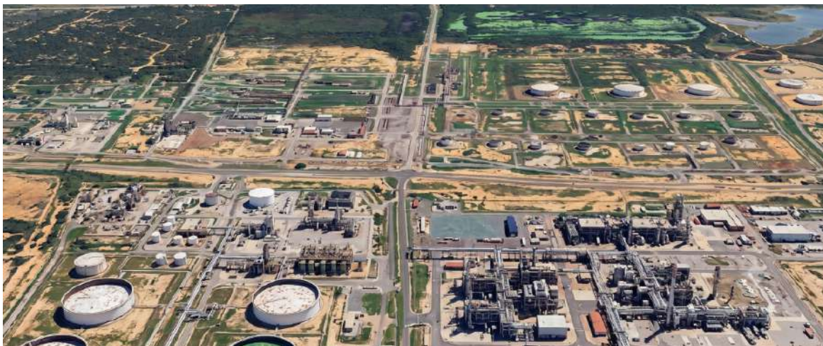
Complejo Petroquímico de Jose, Anzoátegui en Venezuela (Vista aérea)
